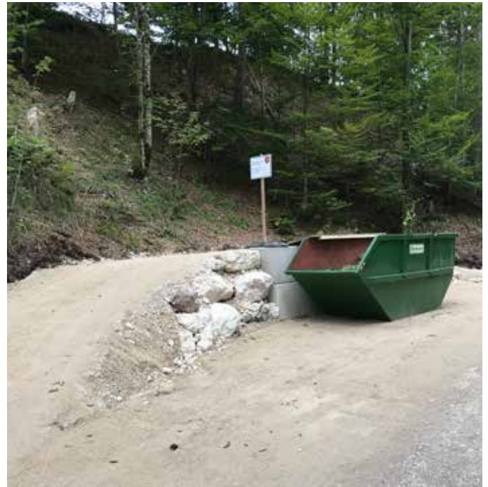
Bei den Grünschnittcontainern in Archkogel/Au und Schachen wurden Rampen zur Erleichterung beim Abladen errichtet.
