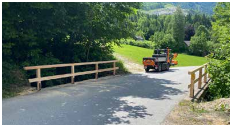
Diverse Brückengeländer mussten altersbedingt erneuert werden.
