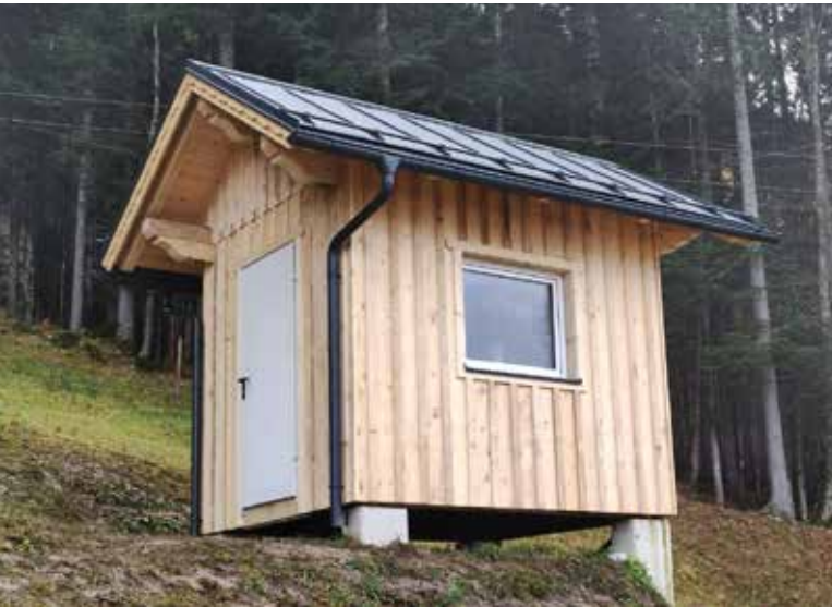
Die neue Bergstation beim Zlaimlift.
