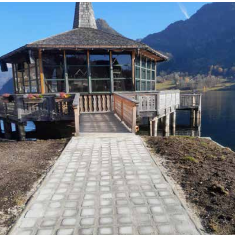
Neu gepflasterter barrierefreier Zugang zum Pavillion.
