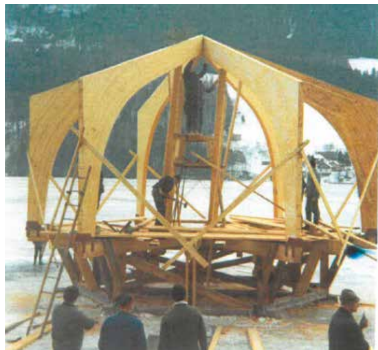
Bau des Seepavillions im Winter 1970/71.
