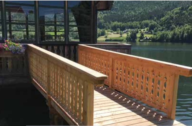
Im Zuge der Sanierung der Uferverbauung wurde der Zugangssteg beim Pavillon neu gestaltet.
