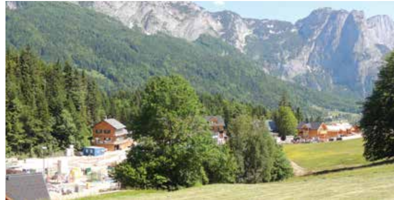
Bei der Liftanlage wurden viele Arbeiten durchgeführt.
