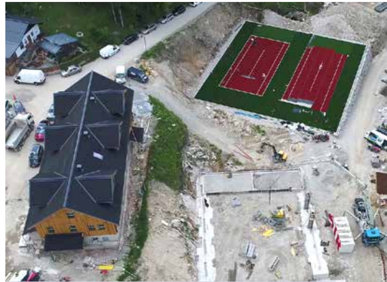
Bei der Multifunktionshalle steht bereits das Fundament – dahinter der neue Tennisplatz.
